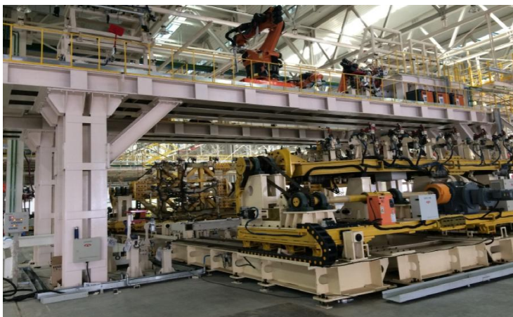
杭州JAS01电动汽车焊装主线项目
